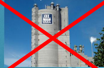
Yara Porsgrunn Ammoniakkproduksjon
